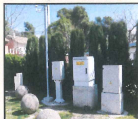
Dans le bassin de Gardanne, 5 stations d'écoute microsismique ont été mises en place afin de surveiller les zones risquant d'être soumises à un affaissement progressif à manifestations cassantes. Par ailleurs, la remontée des eaux est suivie par instrumentation piézométrique de 2 puits.
