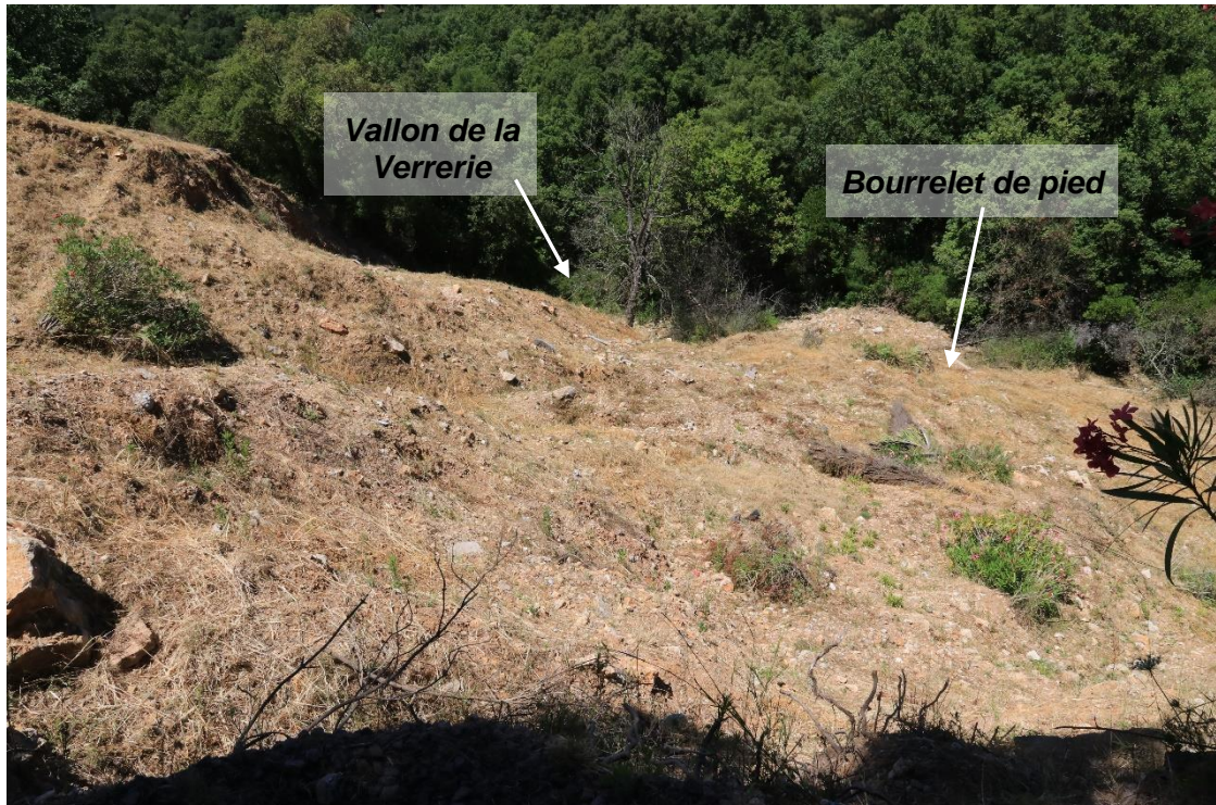
Figure 4 : Bourrelet de pied de glissement et vallon à écoulement temporaire en pied de versant
