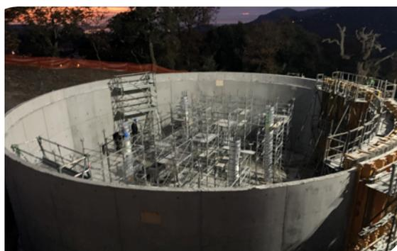
*Construction en cours du réservoir d'eau potable Super Planestel*
