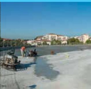
Une résine sera appliquée sur le 3<sup>e</sup> étage à ciel ouvert du parking afin d'assurer l'étanchéité de l'édifice et d'éviter les problèmes d'humidité.
