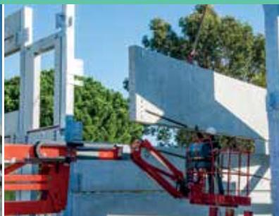
Les poutres sont vissées selon un système d'encoches pour stabiliser la structure et former l'ossature.
