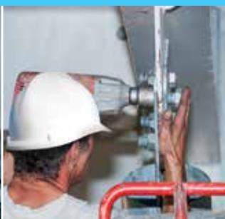
Des trous sont percés dans les obliques pour les stabiliser suite à l'ajout du béton.
