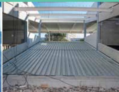
Le plancher collaborant est posé, pour servir de support au béton qui sera coulé plus tard.
