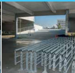
Le béton a été coulé sur le plancher collaborant.
