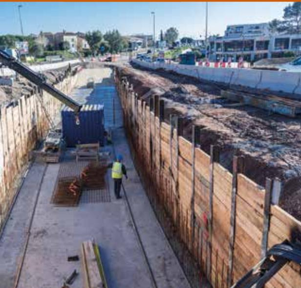
Mise en place des étais pour les panneaux de coffrage et bétonnage des murs de soutènements côté Roquebrune-sur-Argens-Giratoire A8.
