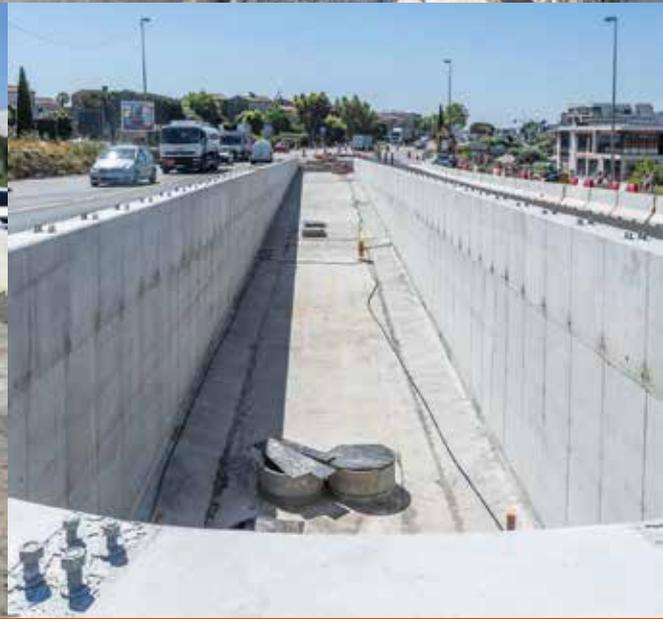
Évacuation des panneaux de coffrages et préparation des plateformes routières côté Fréjus-Giratoire A8.
